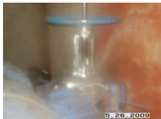
Manhole 13 New Condensate Valve
