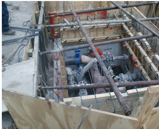
Manhole 10 Manhole Rebuild
