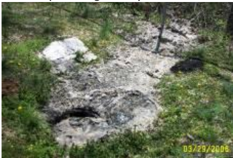
Las grasas y Los aceites son la causa del desbordamiento de el drenaje Sanitario
